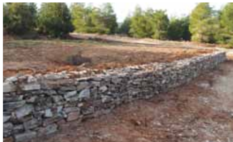
Κατασκευή ξερολιθιάς στην Κόσιη
